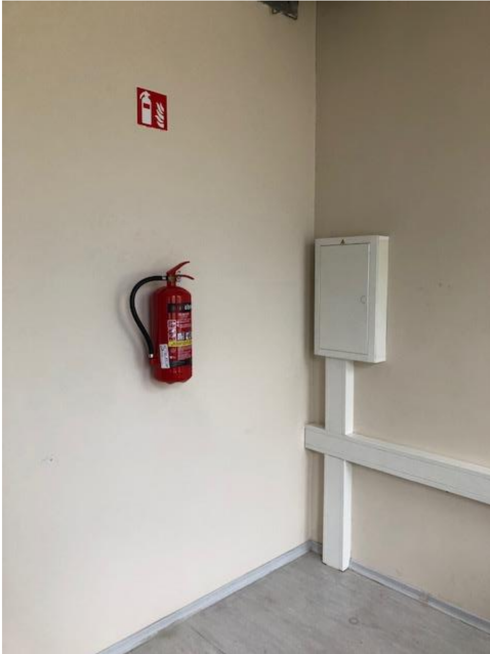
Pilt 1. Kohtkindlalt paigaldatud tulekustuti
